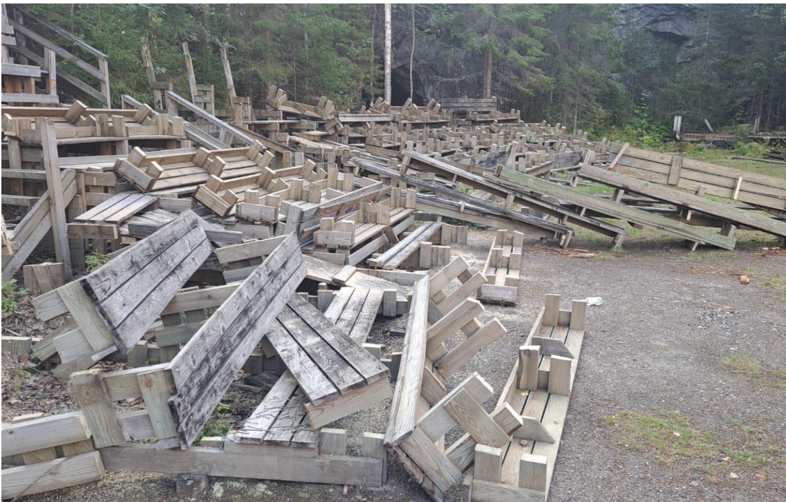
30.8.2024 vanhan katsomon purkuvaihe käynnistyi
